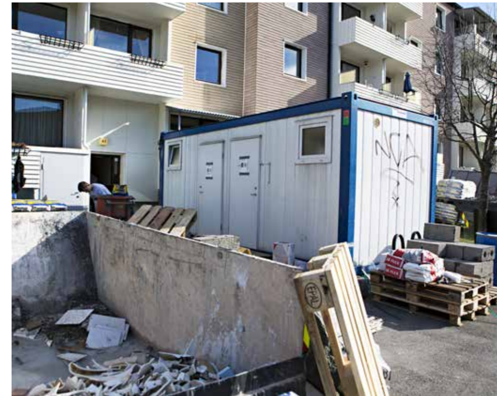
PROVISORISK: Når beboere mister tilgang til vann og avløp under rehabiliteringen, settes det som regel opp provisoriske toalettmuligheter så det er mulig å fortsatt bo hjemme.
