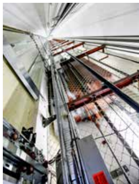
▶ De to heissjaktene er ved siden av hverandre. De brede, røde kanaljernene er skåret bort nærmest veggen ved døren, og erstattet med en smalere brakett. Det har utvidet sjakten og gir plass til de automatiske dørene når de åpnes.
