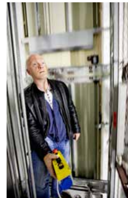
▶ Steinar Eriksen fra Heiskonsulenten AS prøvekjører den nye heisen, stående på taket av kupeen.
