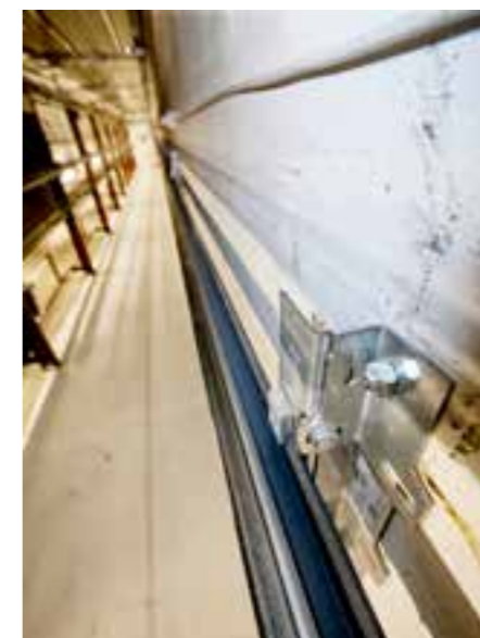
▶ Skinnegangen må være 100 prosent lodd (det vil si vertikalt helt rett), men veggen den skulle festes i var ikke det. Entreprenøren måtte derfor justere alle festemekanismene opp hele veggen slik at avstanden ble riktig og skinnegangen lodd.
