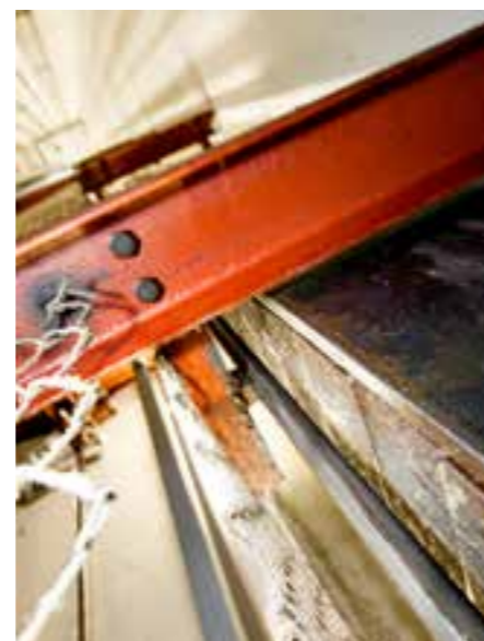
▶ Motvekten (den brune klossen) var det eneste som ikke ble skiftet ut i den store heisen. Ettersom den nye heisen fikk økt kapasitet måtte motvekten balanseres med en ekstra plate, slik at vekten ble riktig.
