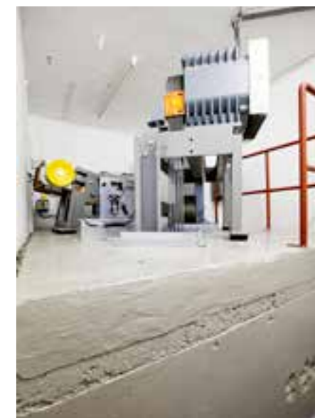
▶ Begge heismotorene er skiftet ut. Bena står på gummi som absorberer vibrasjonene, og gjør motoren lydløs.
