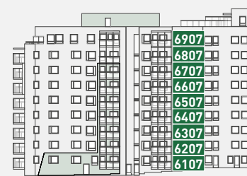
Fasade sett fra øst
