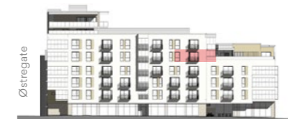
Fasade nord-vest, mot Vangsvegen
