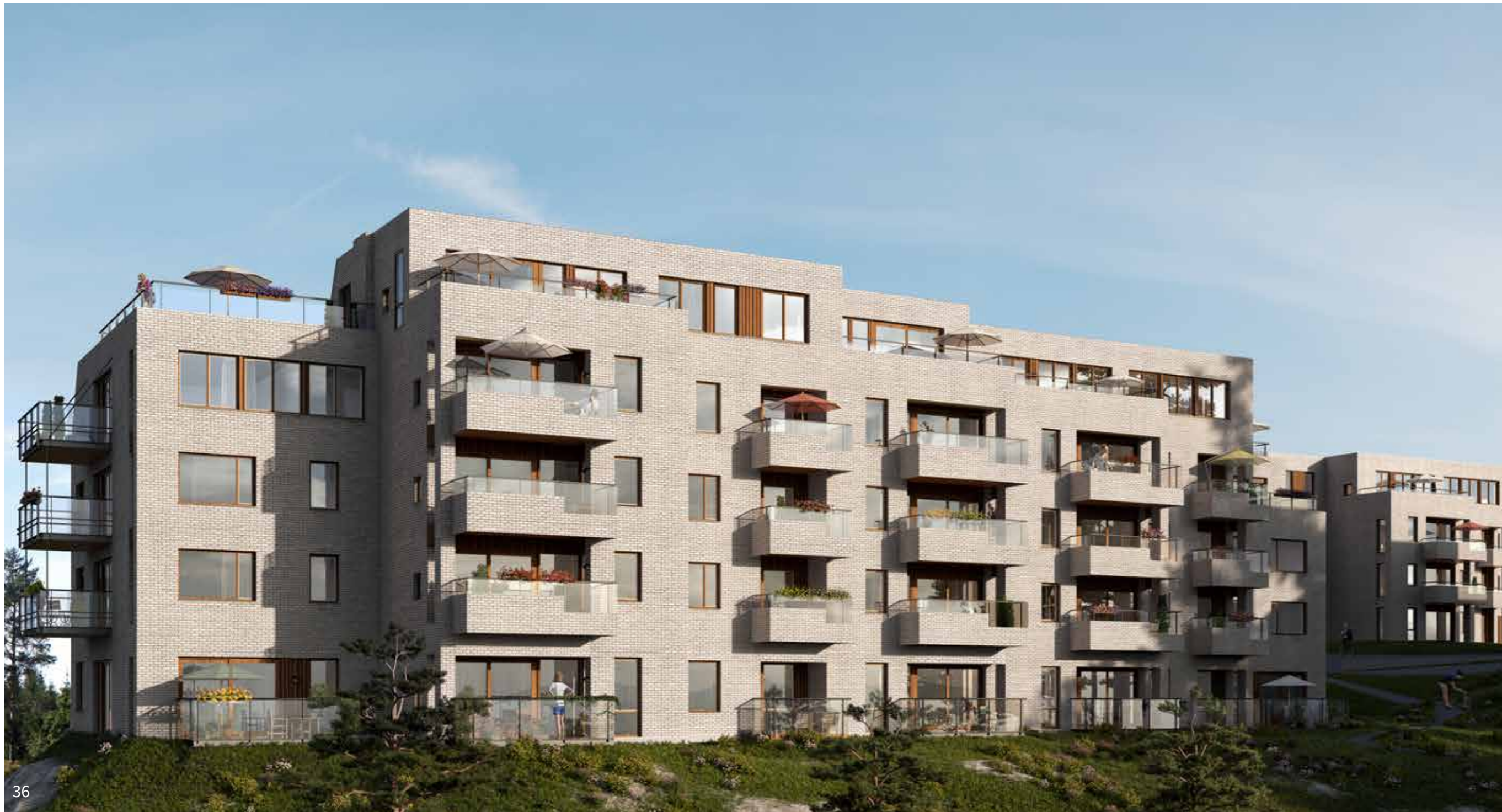
Hus J: Fasade mot nord-vest.
