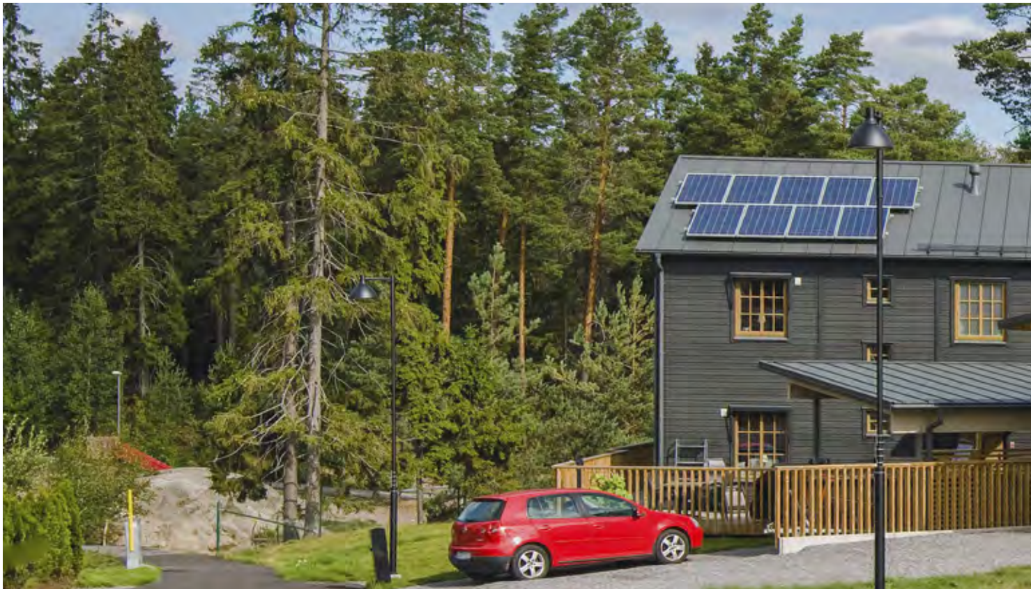
I Brf Trollskogen i Västra Balingsnäs, Huddinge, har OBOS byggt 28 bostadsrätter som friliggande villor. Alla med solpaneler på taken.
