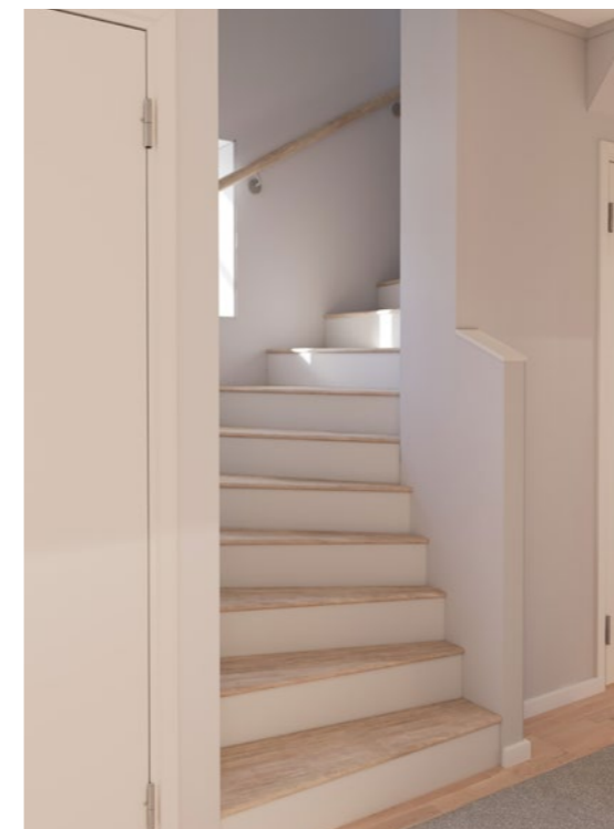
Trappa Tät trappa med plansteg i eklaserad och klarlackad furu med vitmålad sätsteg och vang. Handledare typ Funk i eklaserad och klarlackad furu.
