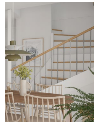
Trappa Tät trappa med vit vang och sättsteg, plansteg i eklaserad och klarlackad furu. Handledare och räcke i eklaserad och klarlackad furu, typ Funk 11 (spjälor av metall)
