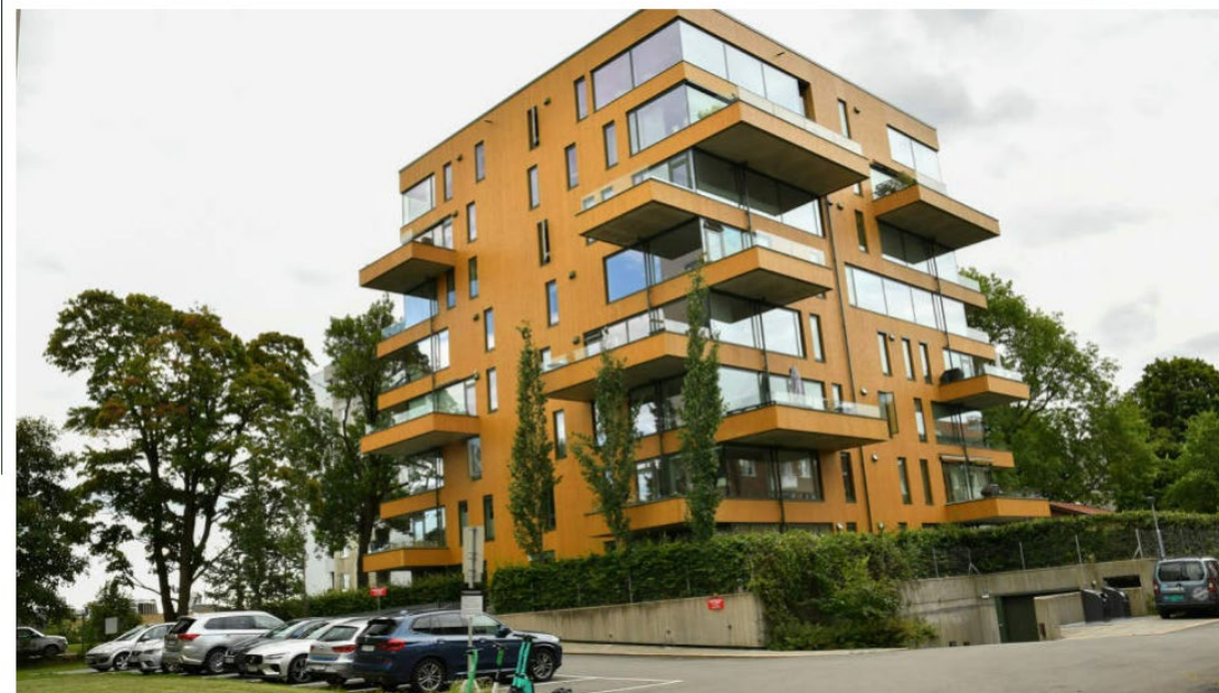
Ullevål Tårn i Nedre Ullevål 5 i Oslo, bygget av Solon Eiendom, FOTO: HELGE HØIFØDT
