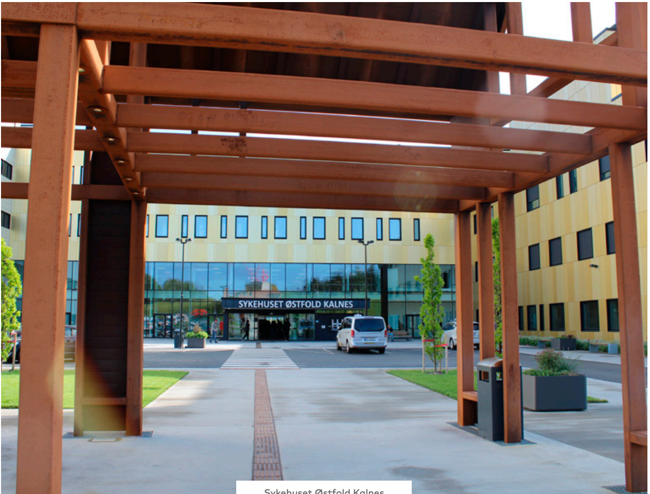
Sykehuset Østfold Kålnes
