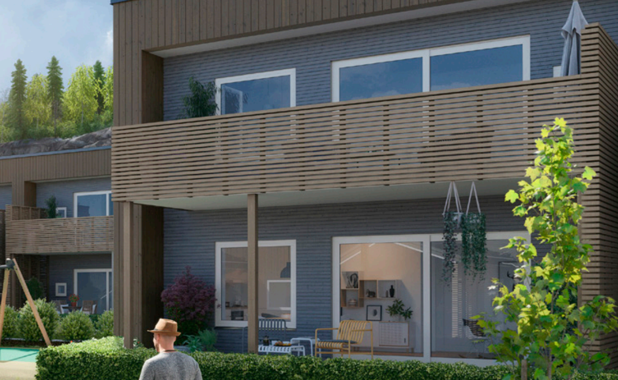
Bilde til venstre Fellesareal med lekepass.
