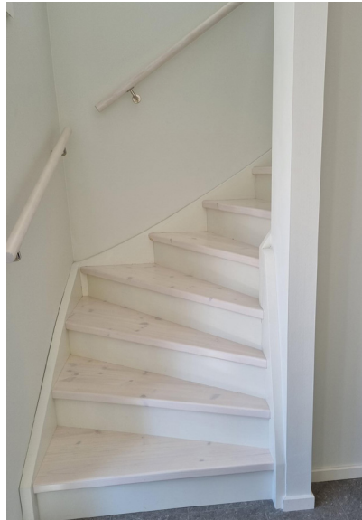
Tät trappa inkl. vang och sättsteg i vitmålad furu och vitlaserade plansteg. Handledare i vitlaserad furu, typ Funk 11.
