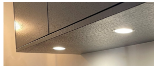
LED spotlights, infällda under väggskåp (2,4 watt)
