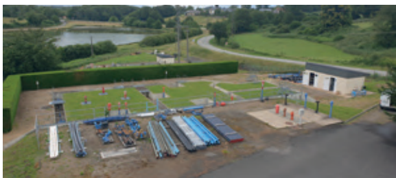
Plateformes pédagogiques de l'OiEau « Réseaux d'eau potable » et « Réseau d'assainissement ». © OiEau
