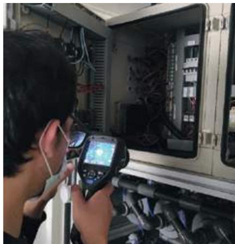
Thermographie infrarouge sur les coffrets électriques d'une unité d'ultra filtration ©OiEau
