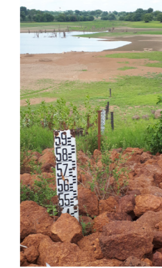
Ferkessédougou - Barrage de la SUCAF à vocation d'irrigation pour la canne à sucre - © OiEau
