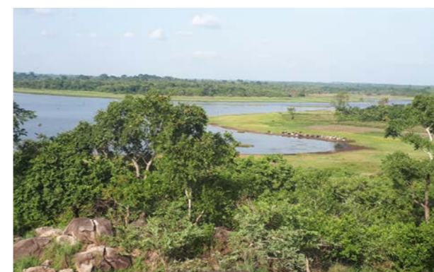
Barrage de Loka, réservoir d'eau brute pour la ville de Bouaké - © OiEau
