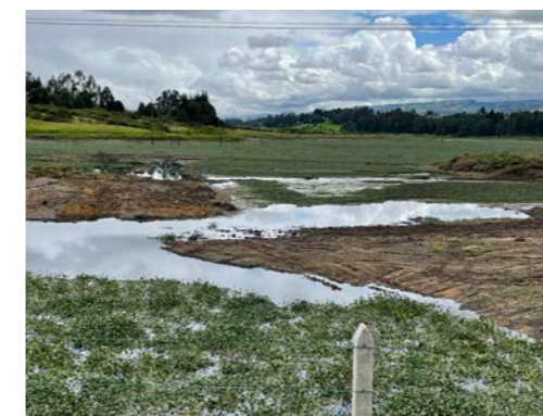
Lagune de la retenue «La Playa» - © OiEau
