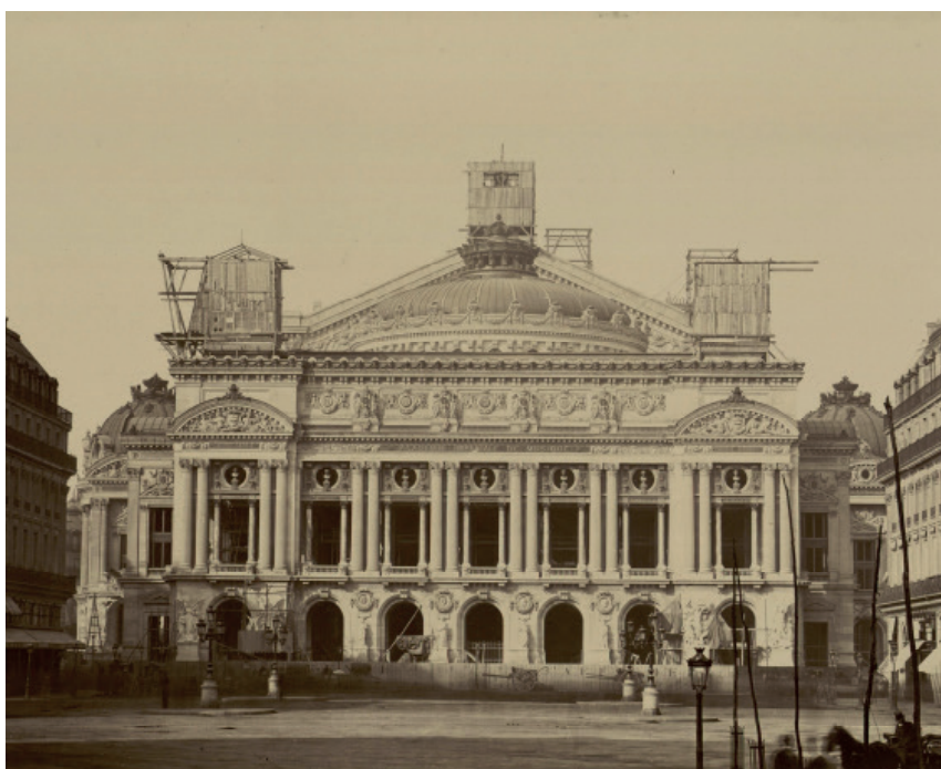
▲ La construction du nouvel Opéra, vue de la façade principale
