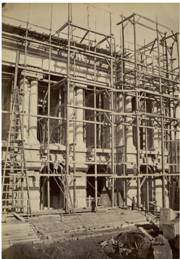
◀ La construction du nouvel Opéra, la façade principale avec les échafaudages
