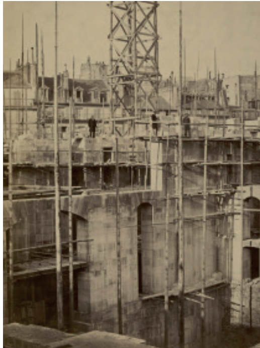
◀ La construction du Nouvel Opéra de Paris, vue des murs de la cuve
