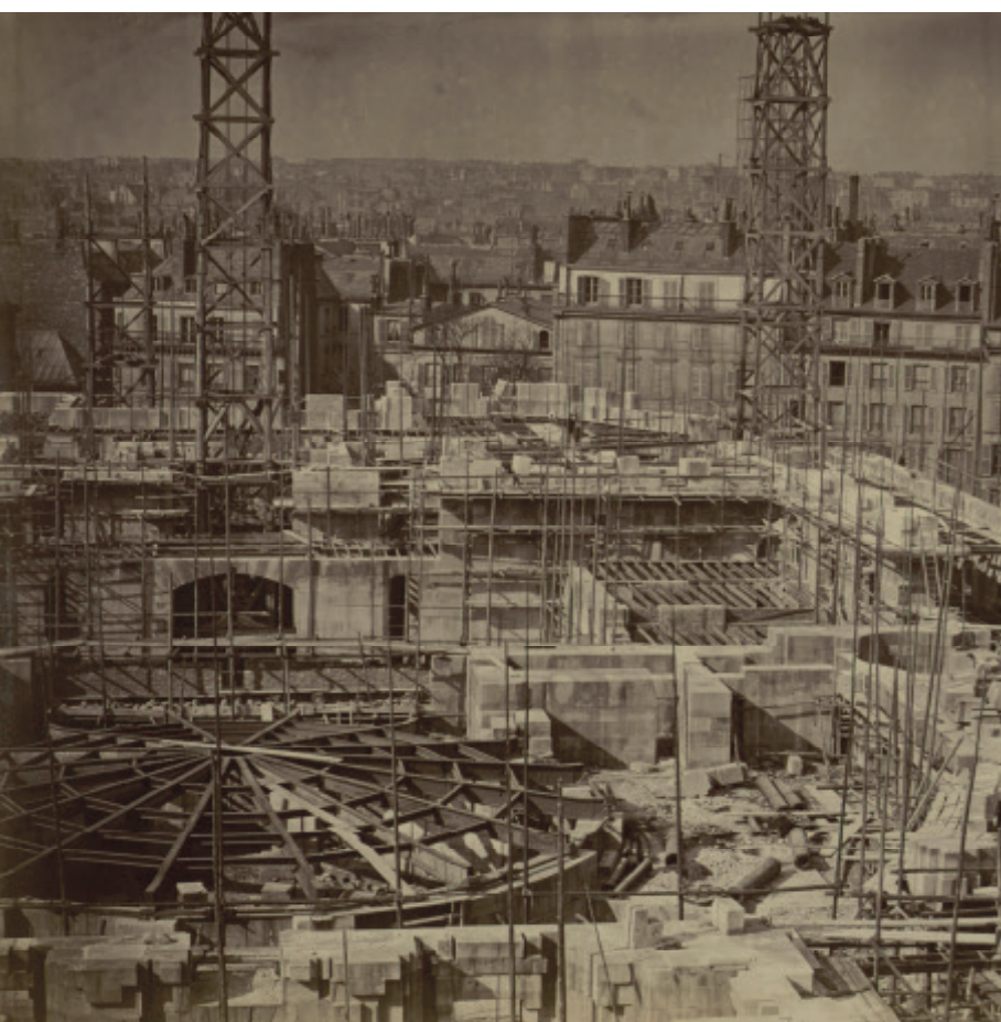
▲ La construction du nouvel Opéra, aperçu de la structure métallique
