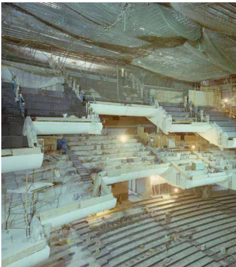
▲ Le chantier de la construction de la grande salle de l'Opéra Bastille
