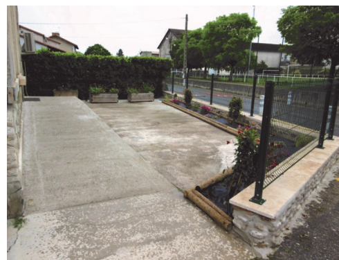
Travaux de la bibliothèque
