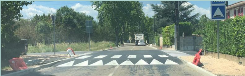
Sécurisation de la départementale au niveau de l'entrée du village côté Lézan
