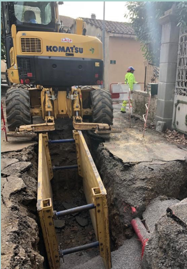
Suite des travaux d'assainissement des Arnasseaux et de la départementale
