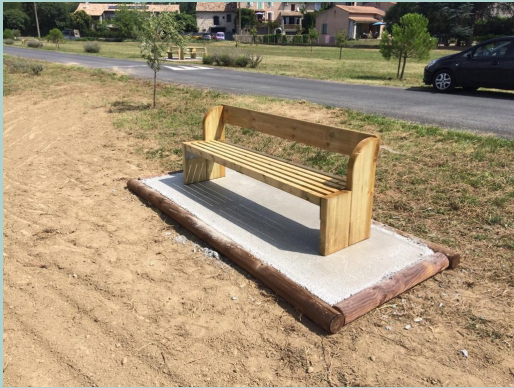
Installation de bancs et de tables de pique-nique au parcours sportif.
