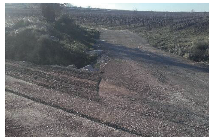
▲ Réfection du chemin des marants
