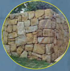
Muros de arrimo
