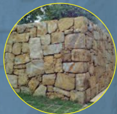
Muros de arrimo
