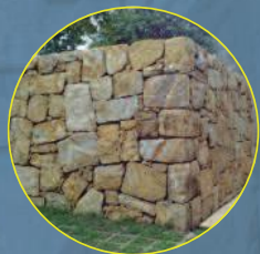
Muros de arrimo
