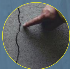
Rachaduras e Fissuras
