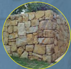
Muros de arrimo
