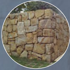
Muros de arrimo
