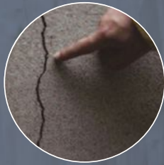
Rachaduras e Fissuras
