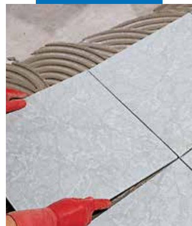
Legging av porselensfliser
