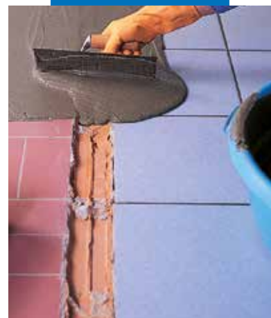
Avretting på eksisterende gulv med Adesilex P4
