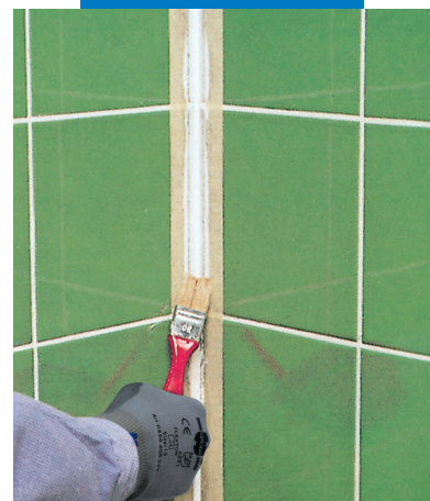
Glattning av fugen med såpevann og en liten kost
