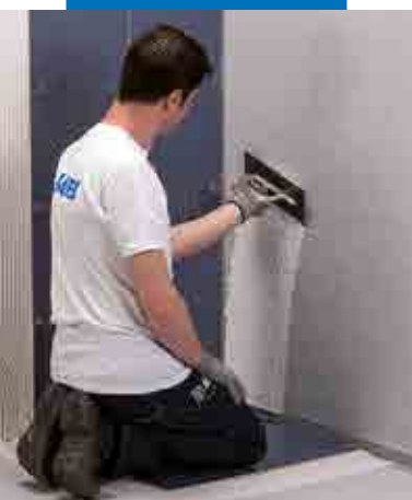
Påføring av flislim
