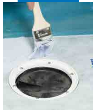
Butylmansjett (selvklebende) legges ned over sluk (på ferdig primet gulv). Deretter påføres Mapegum WPS over mansjett og resten av gulvet.
