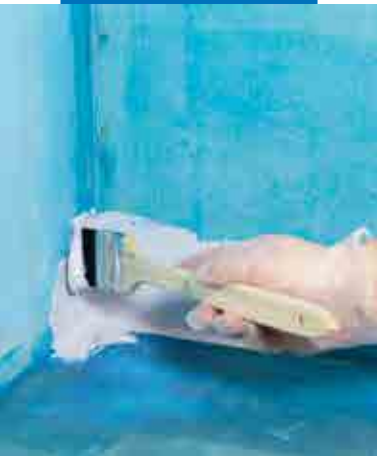
Installering av Mapei IC/EC hjørne mansjett ved hjelp av Mapegum WPS
