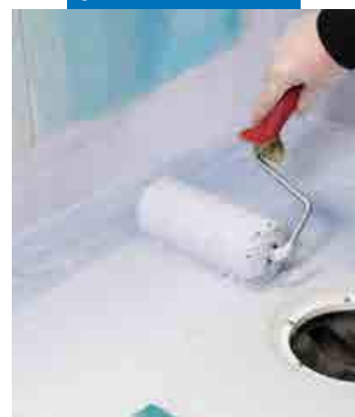
Påføring av Mapegum WPS membran med eksempelvis rulle.
