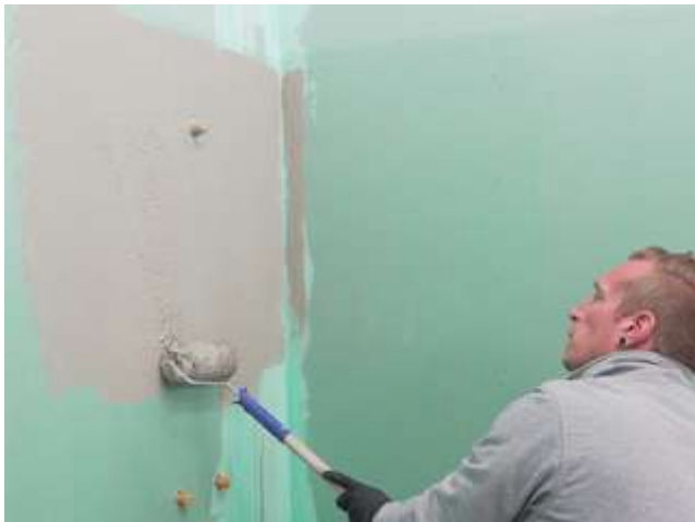
4 Appliquer la Colle fixation & étanchéité sur toute la surface.
