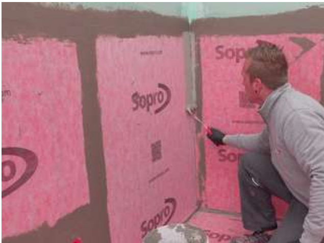
10 Recouvrir les zones de jonction des Membrane Sopro AEB® avec la Bande d'étanchéité flexible Sopro AEB®.
