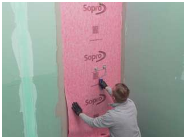
7 Afficher la Membrane Sopro AEB® – coupée aux dimensions exactes – dans la couche de colle fraîche, puis maroufler fermement, du centre vers l'extérieur.
