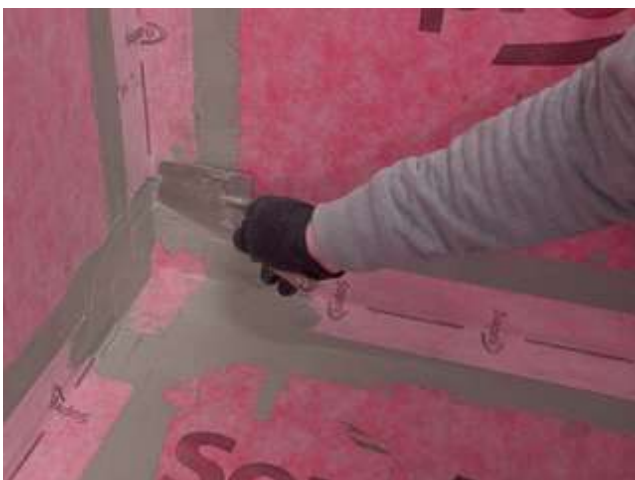
12 Enfin, recouvrir les extrémités des Bandes d'étanchéité Sopro AEB® également avec la Colle Sopro FDK 1180.
