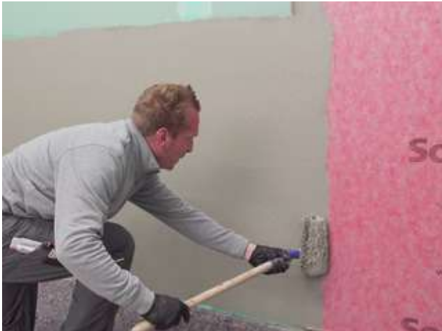
8 Recouvrir les zones de chevauchement avec la Colle Sopro FDK 1180 sur environ 5 cm.
