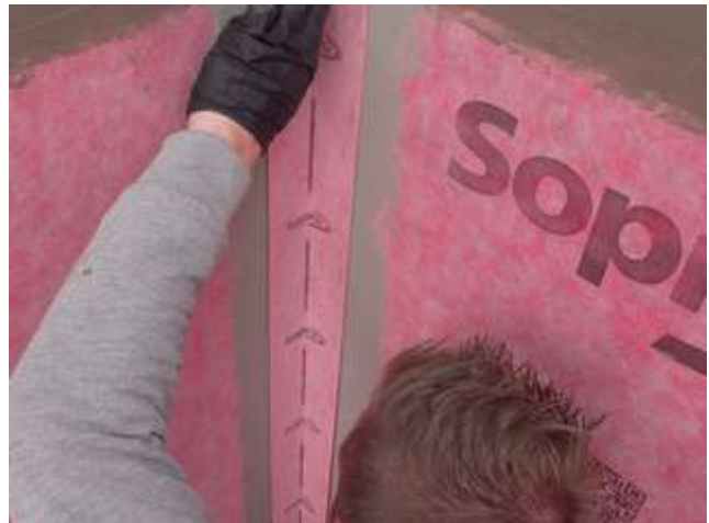
11 Afficher la Bande d'étanchéité flexible Sopro AEB® dans la couche de colle fraîche puis maroufler fermement.
