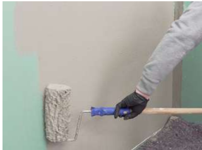
5 Pour un résultat régulièrement couvrant, appliquer la colle en croisant.
