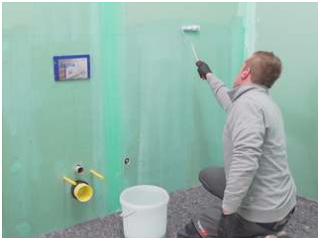
1 Traiter un support absorbant avec le Primaire Sopro GD 749.
