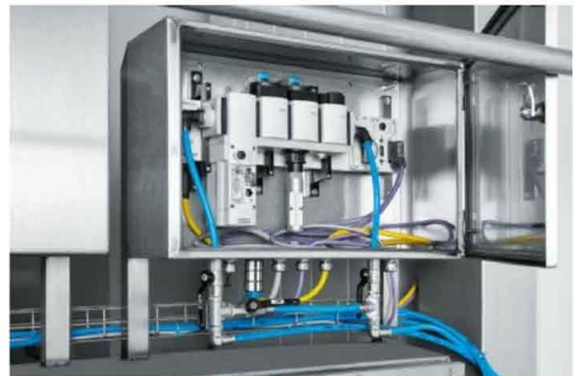
Die erste Generation des Energieeffizienzmoduls MSE6-E2M ist derzeit bei Unilever im Dauerbetrieb. Das marktreife Modul ist rund 50 Prozent kompakter.
