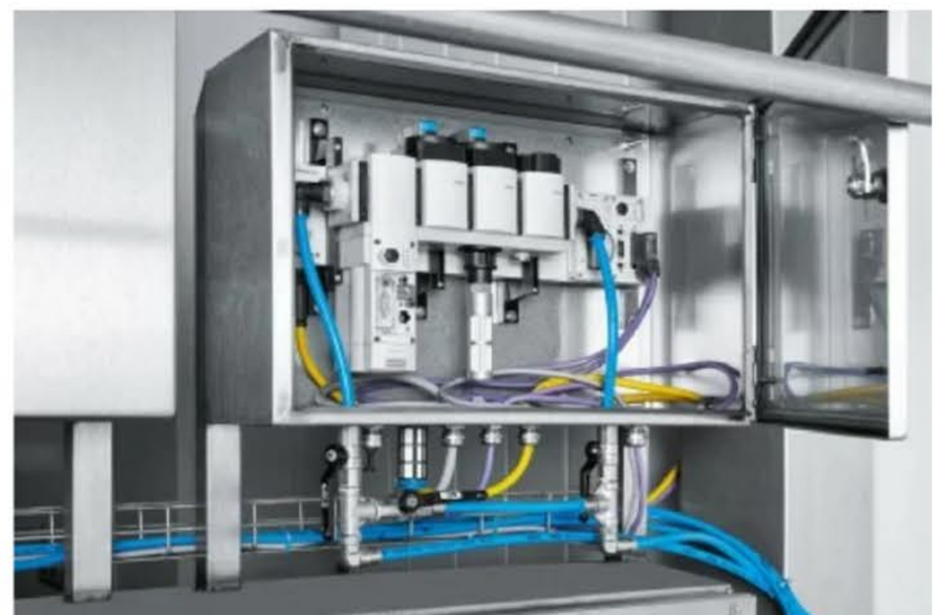
Första generationen av energieffektivitetsmodulen MSE6-E2M används nu kontinuerligt på Unilever. Den marknadsfärdiga modulen är runt 50 procent mer kompakt..
