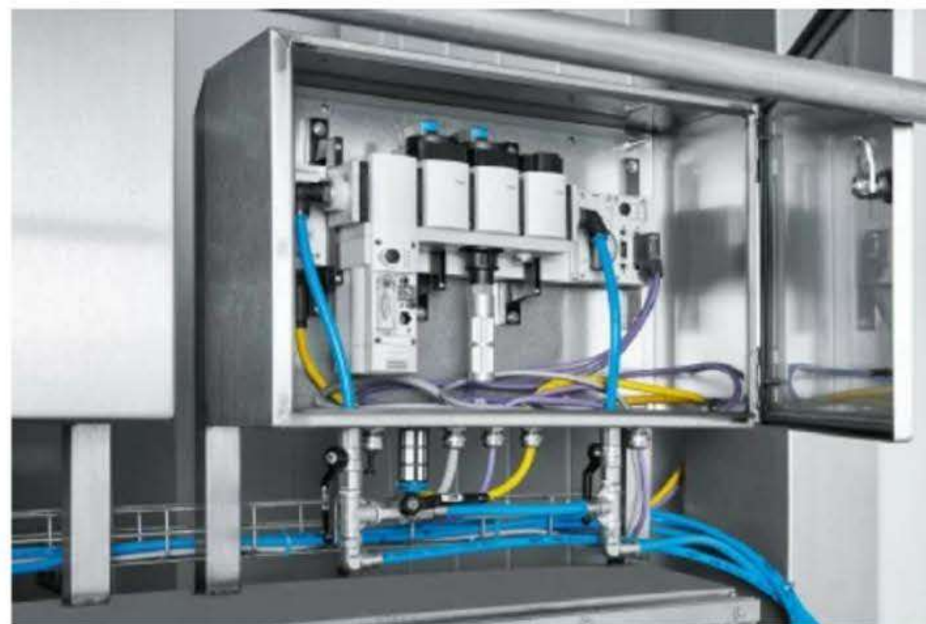
Prvá generácia modulu energetickej účinnosti MSE6-E2M je v súčasnosti v nepretržitej prevádzke v závode Unilever. Modul pripravený na uvedenie na trh je približne o 50 % kompaktnější.
