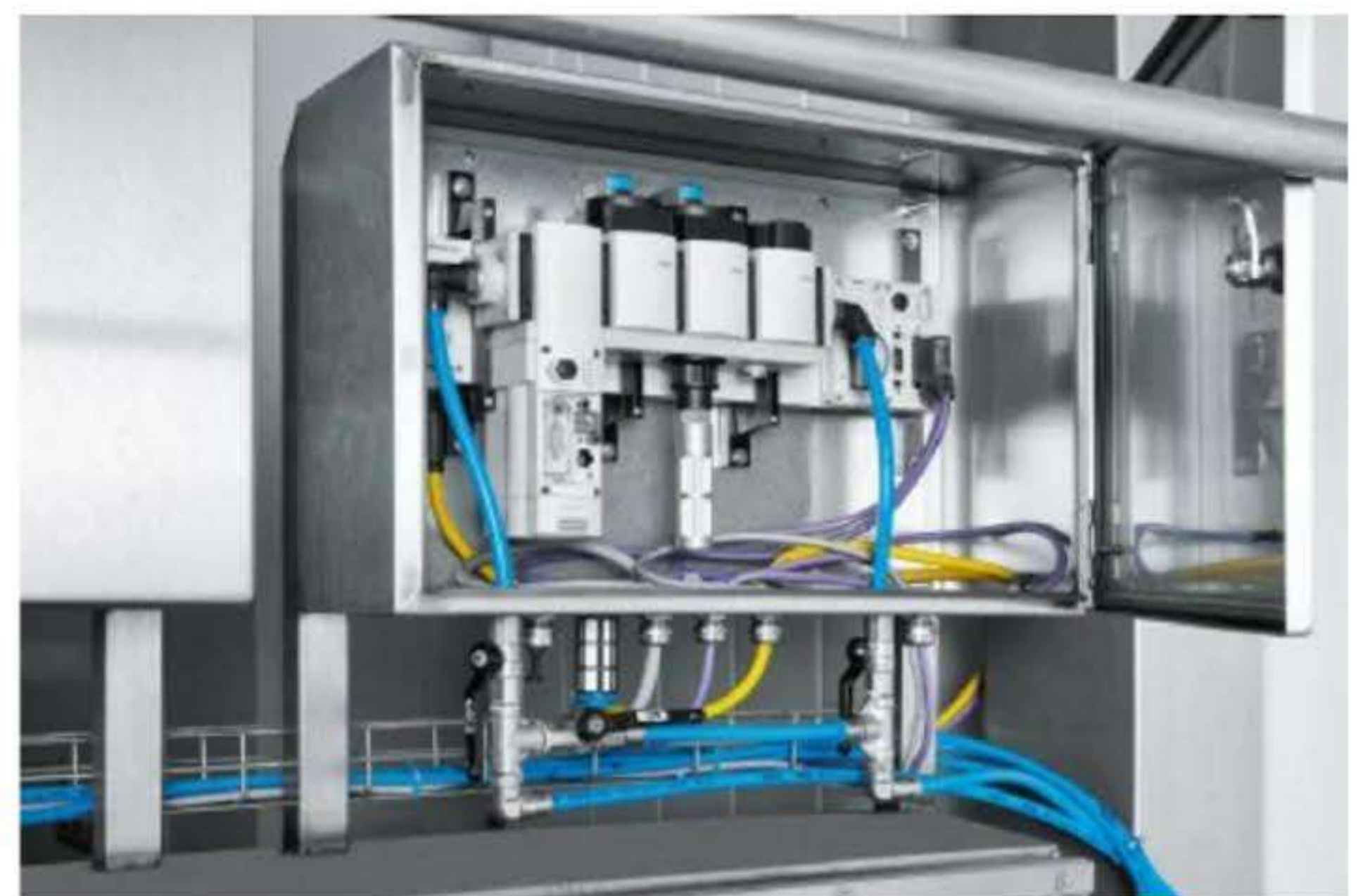
De eerste generatie van de energie-efficiëntiemodule MSE6-E2M is momenteel in continu bedrijf bij Unilever. De marktklare module is rond 50 procent compacter.
