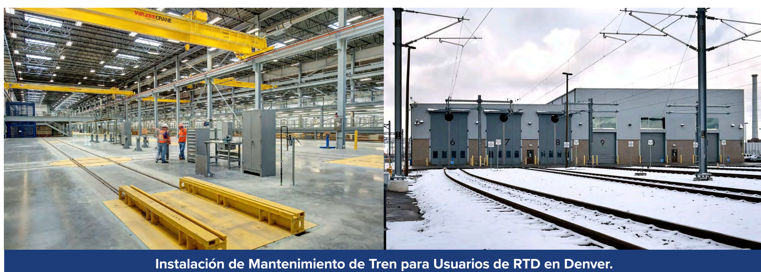
Instalación de Mantenimiento de Tren para Usuarios de RTD en Denver.
