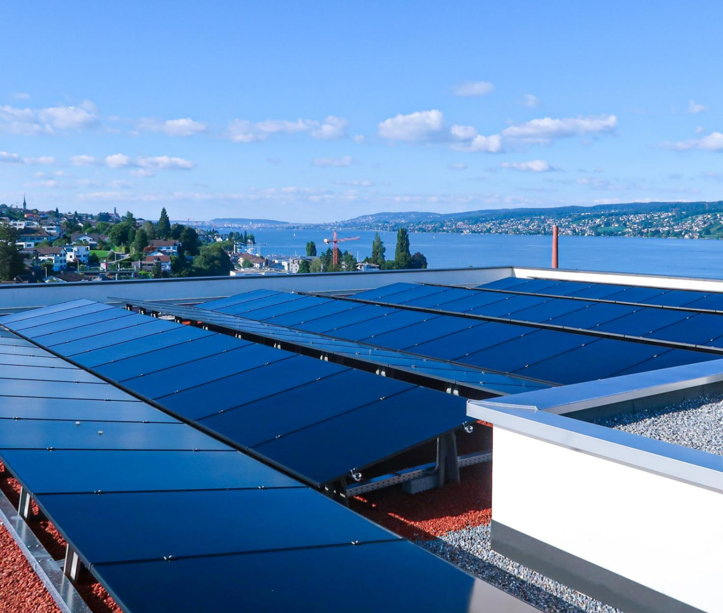
Mit der Fertigstellung des Neubaus Ende 2024 hat das See-Spital auch eine neue Photovoltaikanlage in Betrieb genommen. Die 328 Solarmodule produzieren jährlich 149'000 kWh sauberen Strom, was dem Energiebedarf von rund 30 Einfamilienhäusern entspricht.
