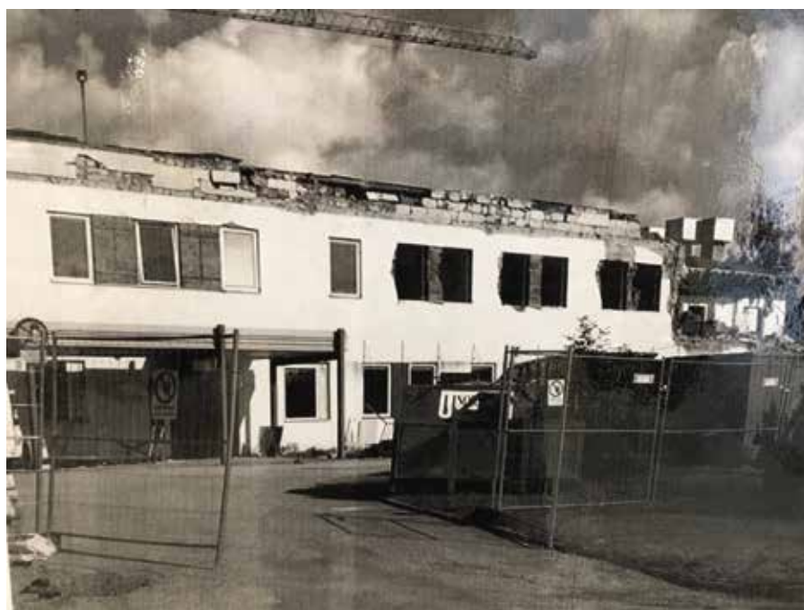
Sjukstugan, dvs. övervåningen med vårdplatser, rivs. Läkarstationen, dvs. undervåningen, byggs om till vårdcenter.
