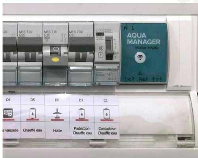
Nouveauté dans l'Ecosystème Muller Intuitiv, l'Aqua Manager s'installe au tableau électrique et se raccorde au relais HC du chauffe-eau électrique.
