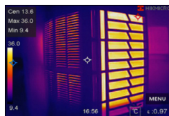
INSPECTION DES SYSTEMES DE CHAUFFAGE
