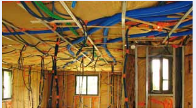
5 . Croisement de conduits Flexigaine sous l'épaisseur d'isolant
