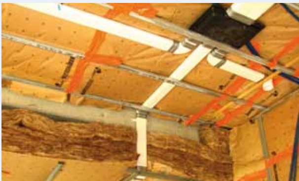
8 . Raccordement de la Minigaine 200 x 60 mm sur le plénum de soufflage plat
