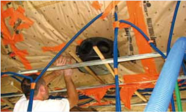
1 . Mise en place des caissons de répartition pour l'extraction et l'insufflation
