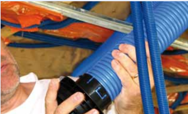
1 . Mise en place des caissons de répartition pour l'extraction et l'insufflation
