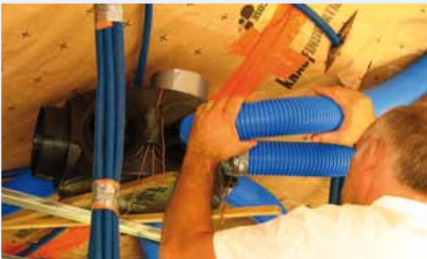
2 . Raccordement de Flexigaine sur le caisson répartiteur
