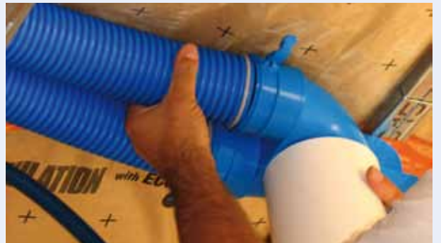
4 . Mise en place du kit d'extraction cuisine Flexigaine
