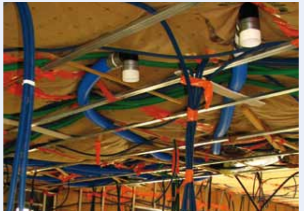
6 . Kits de soufflage / extraction en attente des cloisons et des bouches
