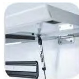
Trappe d'accès aux filtres Piston d'ouverture pneumatique
