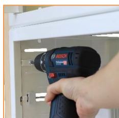
Visser les pattes du cadre sur le bac
