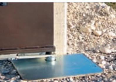
**Il vaut mieux y penser avant !** L'installation du FROG est simple mais nécessite la pré-installation la caisse de fondation.
