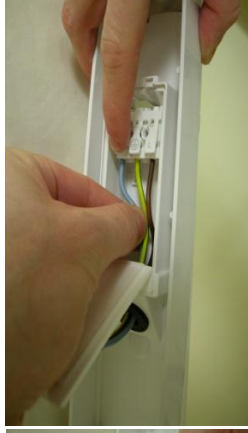
Raccorder au réseau
