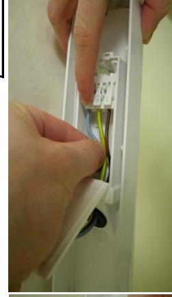
Raccorder au réseau
