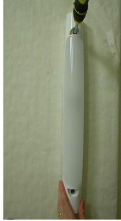
Fixer à travers l'applique et tester l'allumage.
