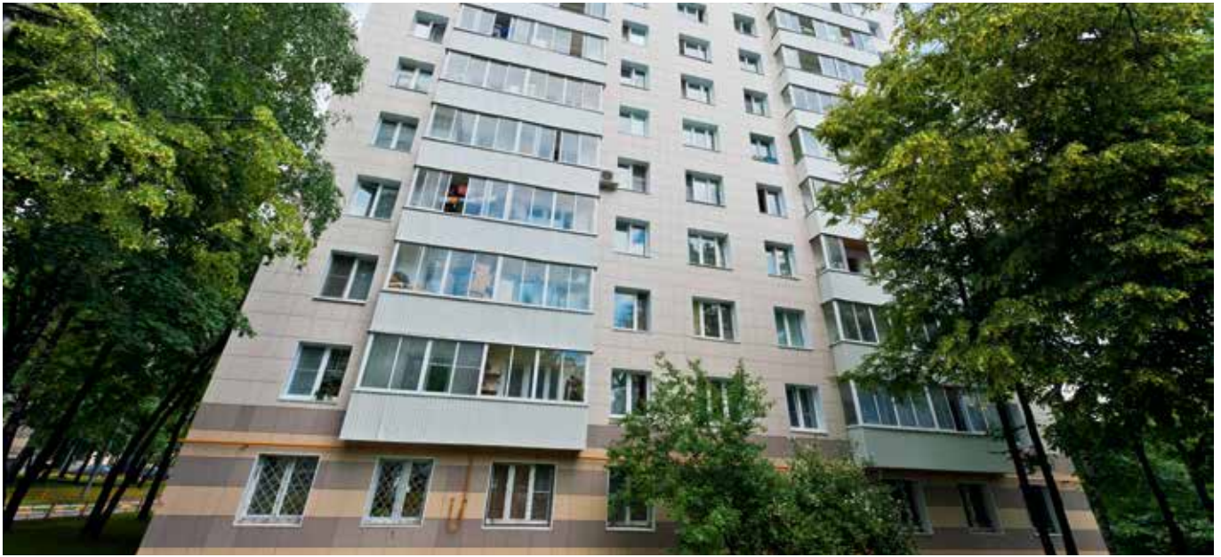
Moscou, Russie : bâtiments résidentiels raccordés au chauffage urbain.
