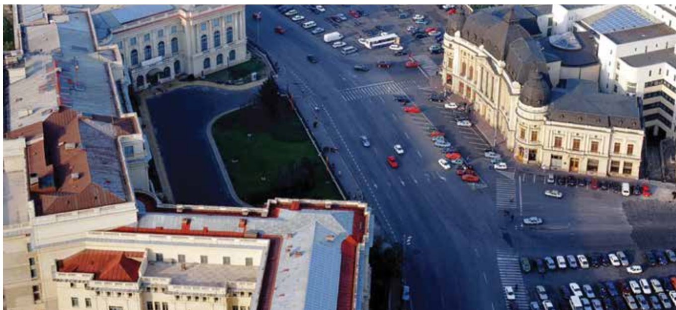
Bucarest, Roumanie : bâtiments collectifs et commerciaux raccordés au chauffage urbain.
