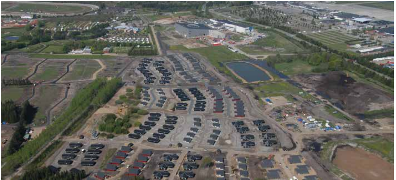
Billund, Danemark : maisons résidentielles raccordées au chauffage urbain.
