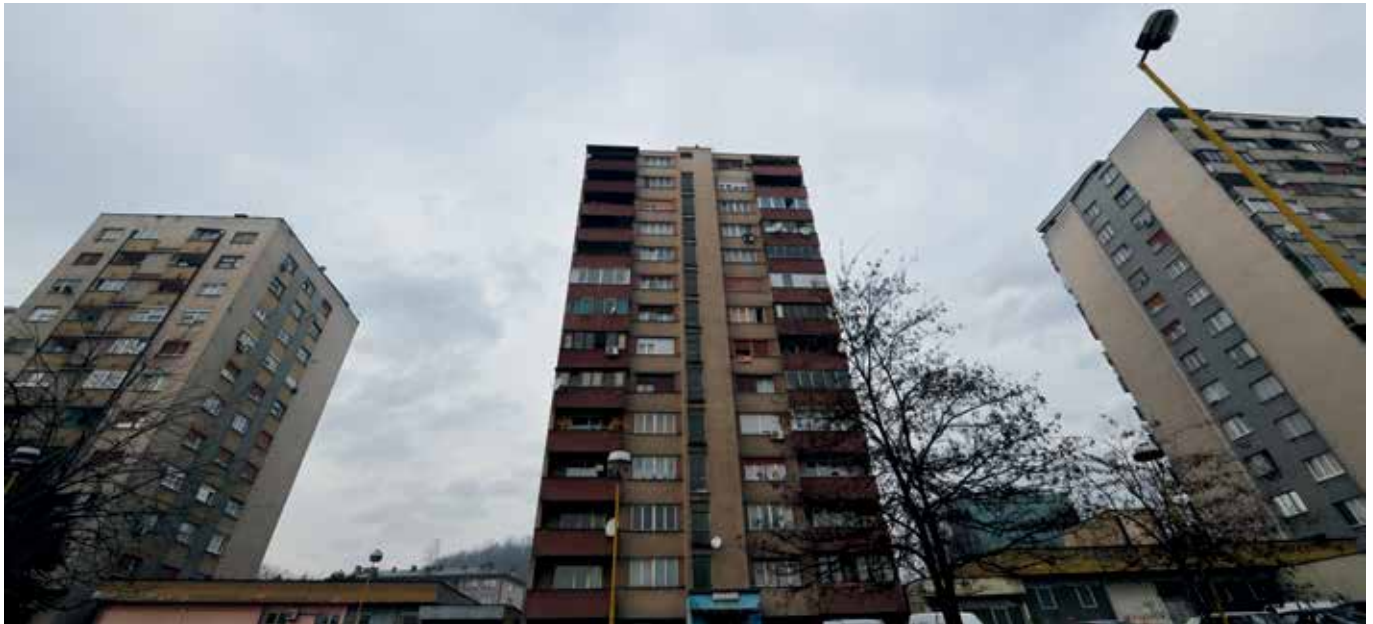
Tuzla, Bosnie-Herzégovine : bâtiments collectifs raccordés au chauffage urbain.
