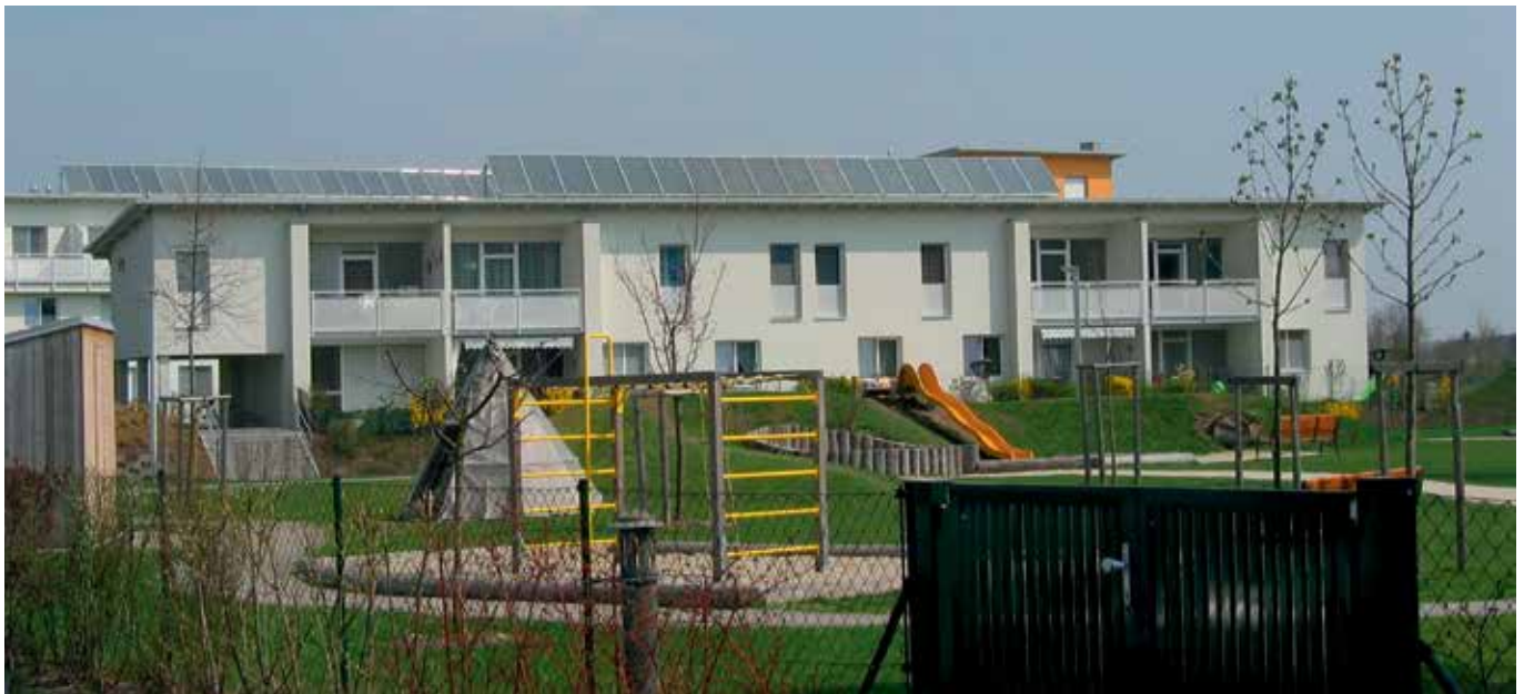
Linz, Autriche : bâtiments collectifs raccordés au chauffage urbain.
