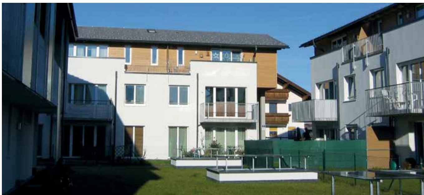
Walz, Autriche : bâtiments résidentiels raccordés au chauffage urbain.
