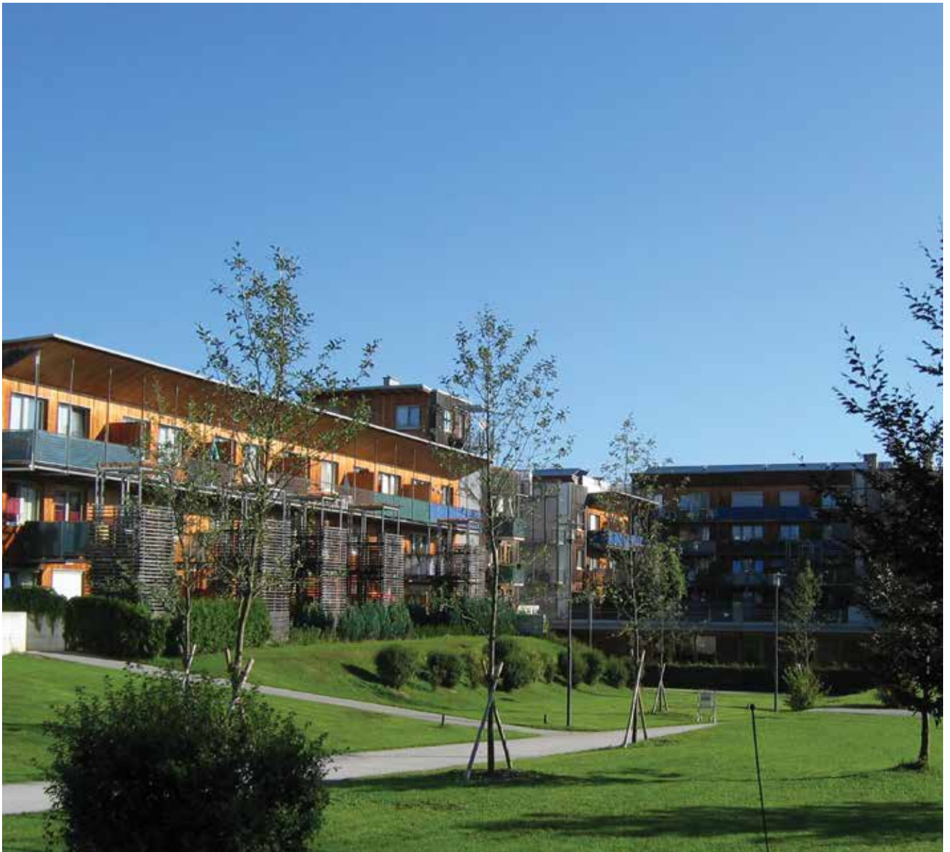
Salzbourg, Autriche : bâtiments résidentiels raccordés au chauffage urbain.
