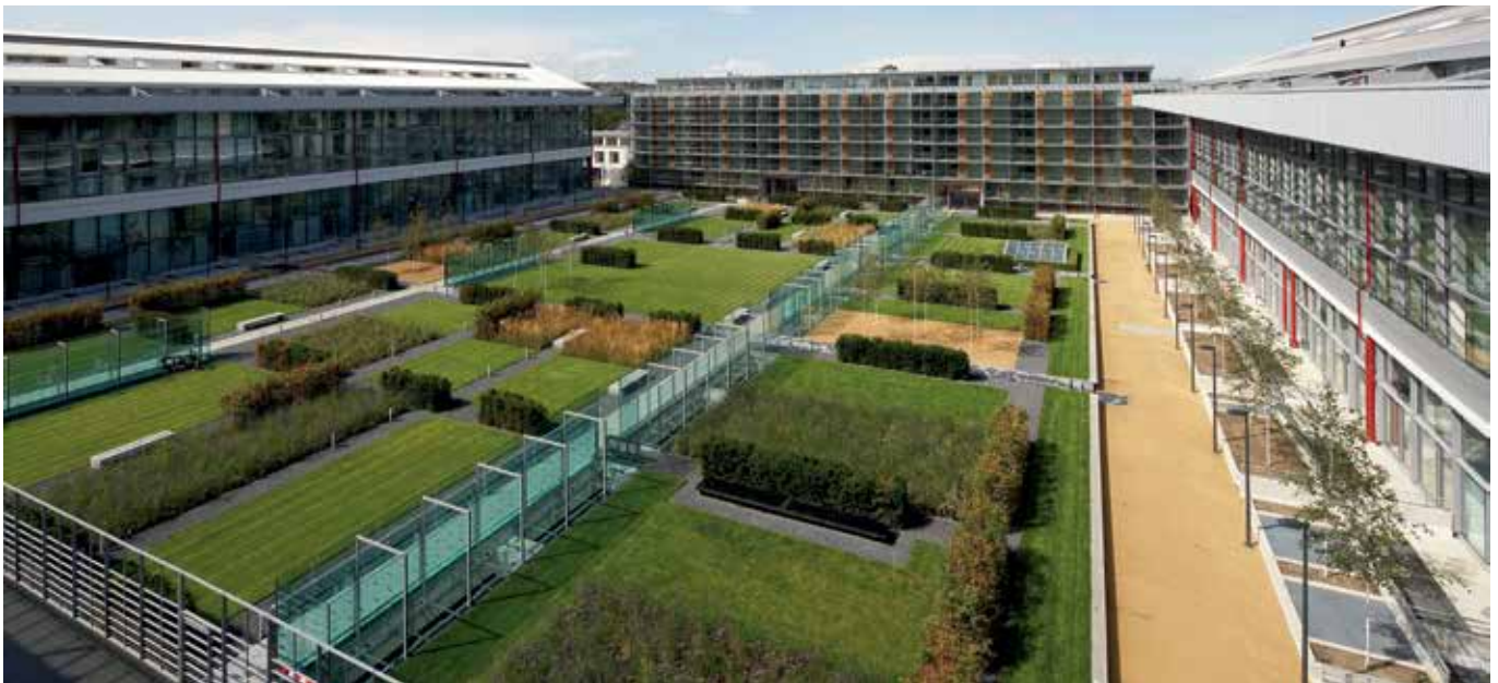
Londres, Royaume-Uni : bâtiments résidentiels raccordés au chauffage urbain avec production instantanée d'ECS.
