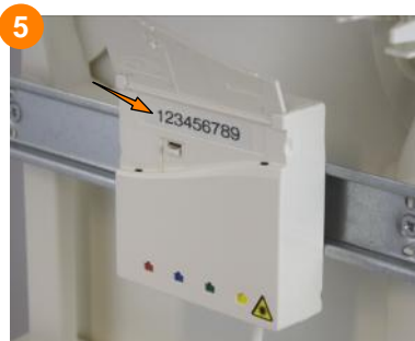
5 Poser les étiquettes d'identification sur le capot (une étiquette collée sous la trappe et l'autre collée à l'intérieur du capot).
