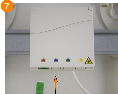
7 Pour faire les mesures de contrôle ou pour raccorder un appareil au réseau optique, brancher un cordon optique sur une sortie du DTIo.
