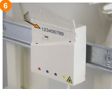
6 Poser les étiquettes d'identification sur le capot (une étiquette collée sous la trappe et l'autre collée à l'intérieur du capot).
