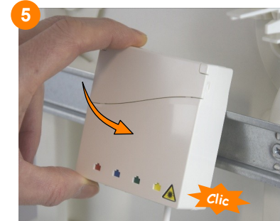
5 Clipper le DTIo sur le rail DIN dans le coffret. Le DTIo peut également se clipper avec les sorties orientées sur le côté.
