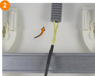
2 Poser le câble optique dans le conduit à l'aide d'une aiguille de tirage (conduit ø20 mini)
