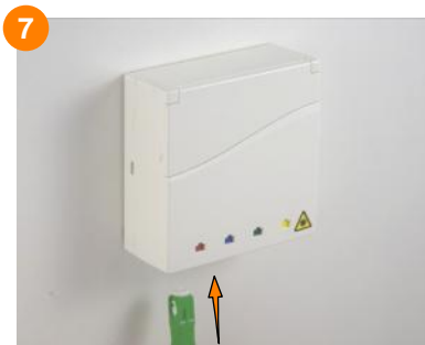
7 Pour faire les mesures de contrôle ou pour raccorder un appareil au réseau optique, brancher un cordon optique sur une sortie de la PTO.
