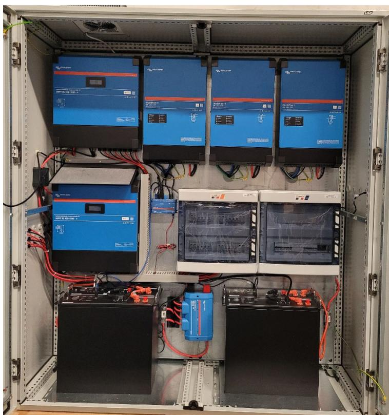
Figure 58 : Modèle 3x5 kVA, 4x3,55 kWh de stockage
