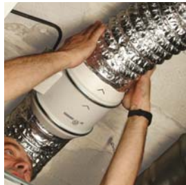
Raccorder les conduits.
