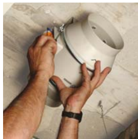
Insérer le corps moteur-hélice.
