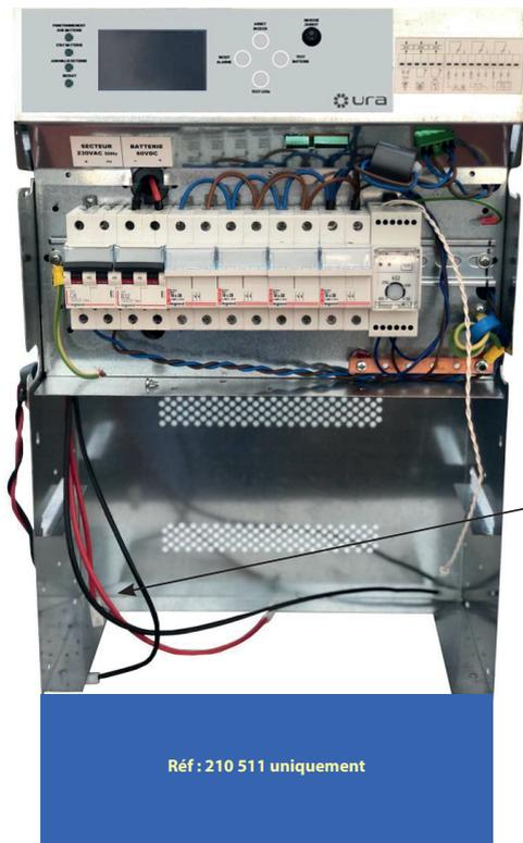
Débrancher et isoler les bornes+ et - généraux de chaque branche.
